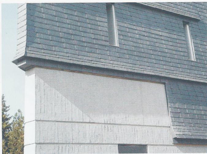
Der Sichtbeton im unteren Fassadenbereich der denkmalgeschützten Kirche wurde dem historischen Erscheinungsbild mit Scheinfugen und Brettstruktur angeglichen.
